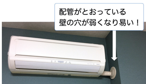
【図6】 エアコンの配管が壁を貫いているところ
